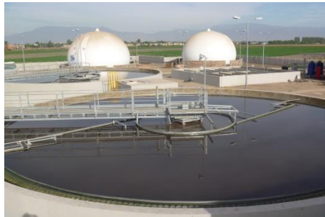
WWTP Compañías Cerveceras Unidas
